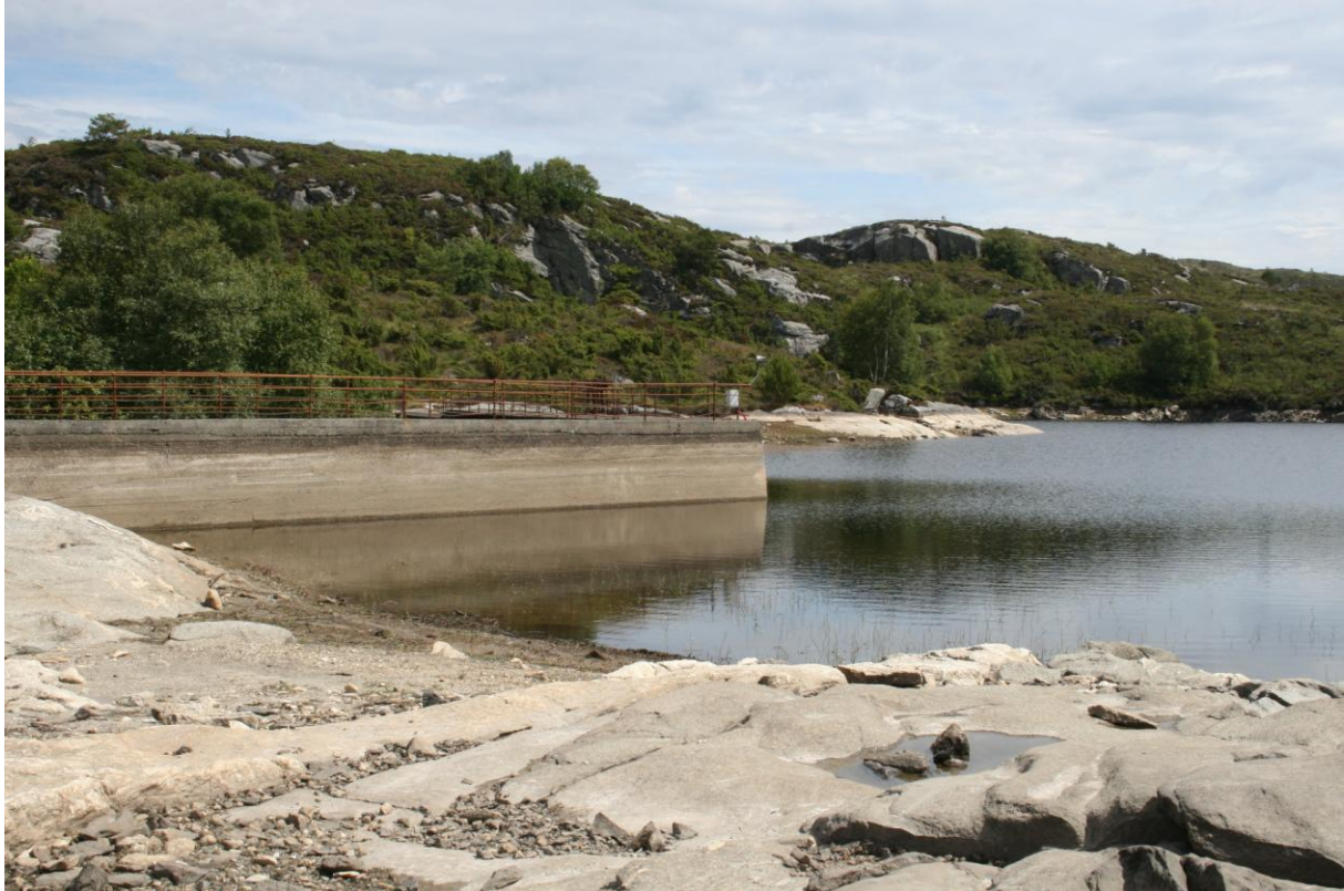
Figur 4.3. Vannivået i Austbøstemmen 8.7.2014. Vannflaten ligger ca. 1,4 m under damkronen.
